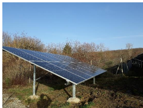
Figure 10 : Exemple de pieux forés bétonnés
