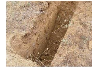
Fouille de sondage
