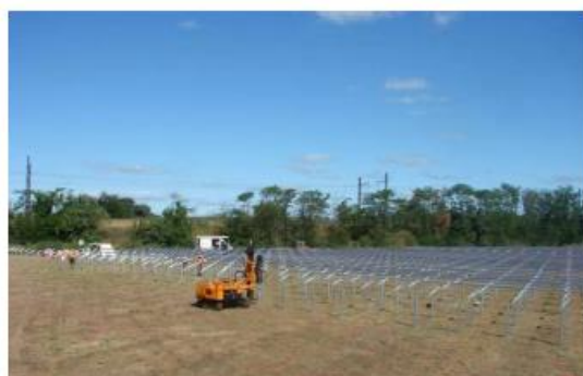
Battage des pieux
