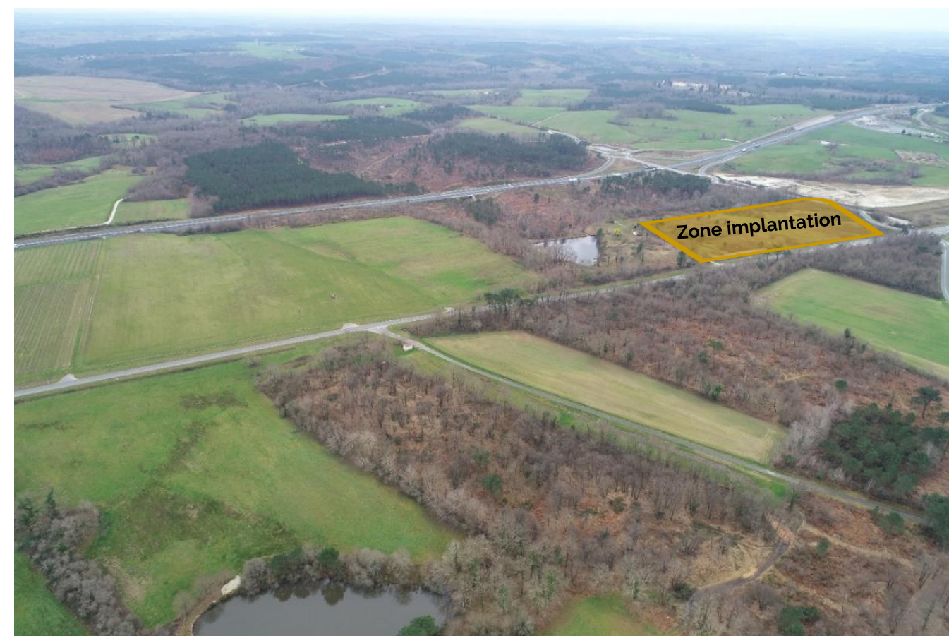
Figure 1 : Photographie du site
