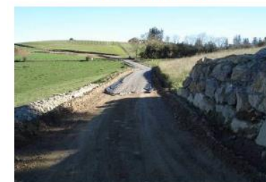
Mise en place du gravier
