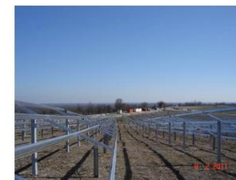
Fixation des rails de support
