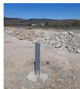
Figure 10 : Exemple de pieux forés bétonnés
