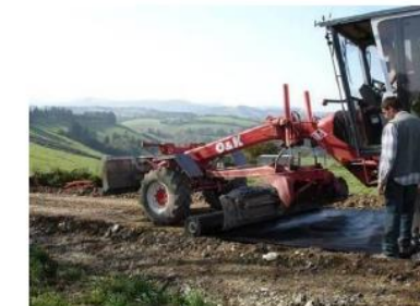
Pose du géotextile
