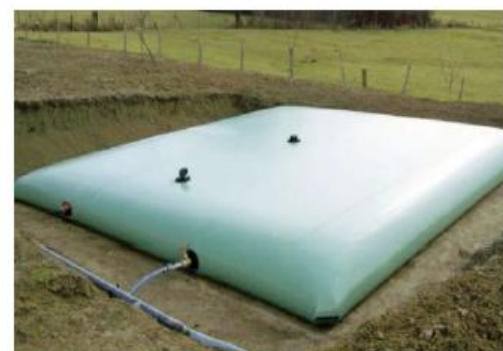
Figure 6 : Exemple de réserves d'eau artificielles métalliques (à gauche) et souple (à droite)
