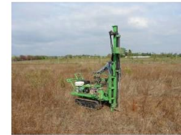
Sondage au pénétromètre
