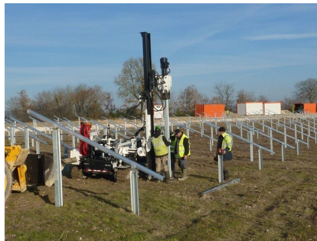
Figure 3 : Mise en place de support de panneaux
